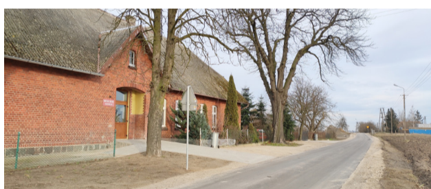
Remont świetlicy w Bagniewie wraz z przebudową drogi
