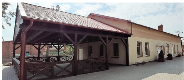
Budowa altany w Brzeźnie
