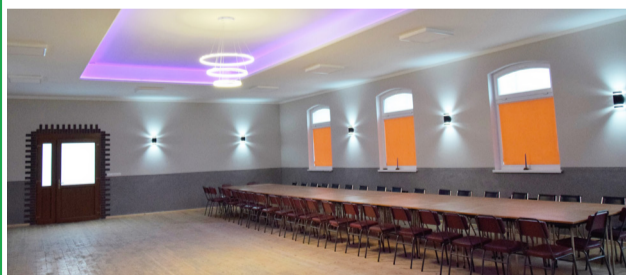
Remont świetlicy w Mirowicach
