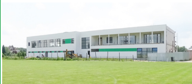
Budowa hali sportowej (inwestycja w realizacji)
