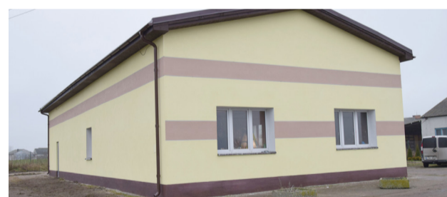
Przebudowa świetlicy w Cieliszynie
