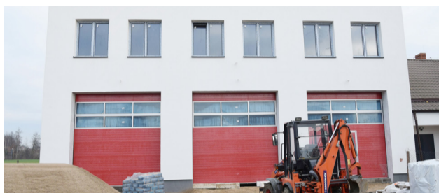
Budowa Remizy OSP w Pruszczu
