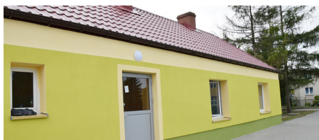
Punkt przedszkolny w Pruszczu
