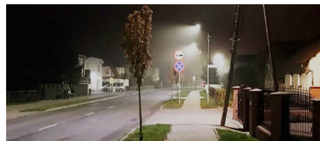
Modernizacja oświetlenia ulicznego na led
