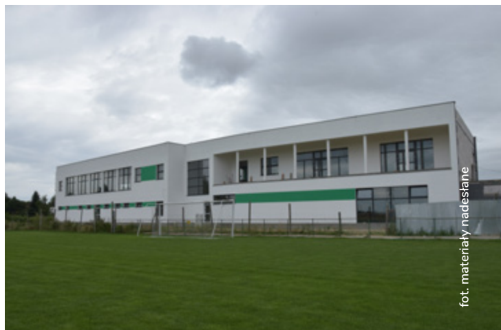
Budowa hali sportowej
